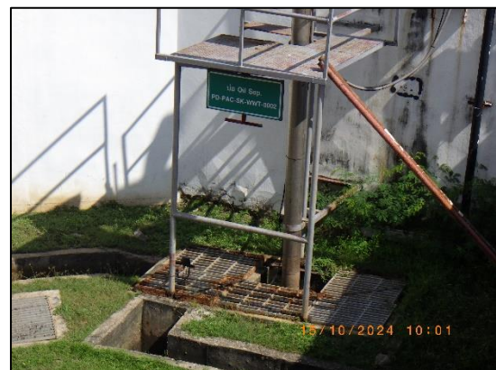
รูปที่ 2-9 บ่อดักน้ำมัน (Oil Separator)
