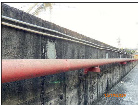
รูปที่ 2-21 กำแพงกันล้อมรอบถังเก็บแอสฟัลท์
