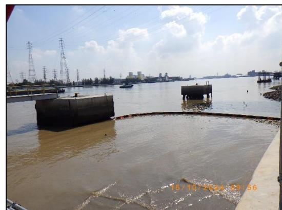
รูปที่ 2-7 การใช้อุปกรณ์ทวนักน้ำมัน (Boom) เพื่อป้องกันการแพร่กระจาย
