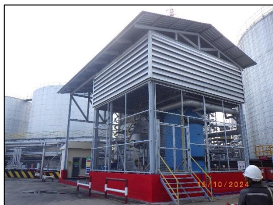
รูปที่ 2-4 ห้องควบคุม Hot Oil (Thermal Fluid Heater)
